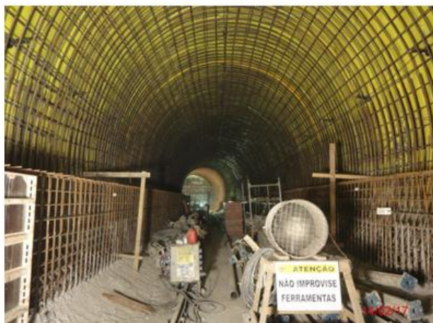
Execução do revestimento secundário do túnel de estacionamento de trens
