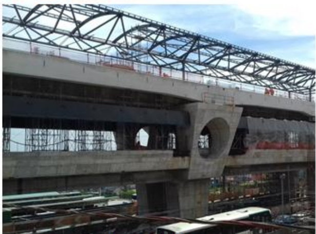
Execução da cobertura da plataforma.
