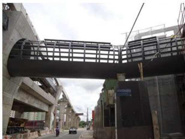
Instalação da passarela metálica do Acesso Norte.
