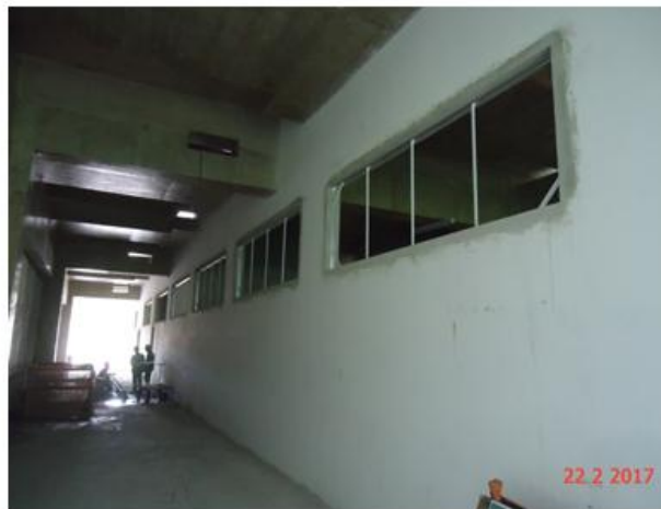
Bloco A: Instalação das esquadrias metálicas
