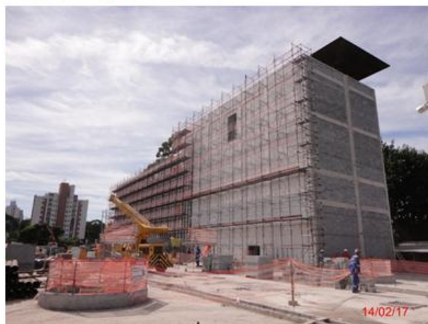
Execução do revestimento externo do edifício de Salas Técnicas
