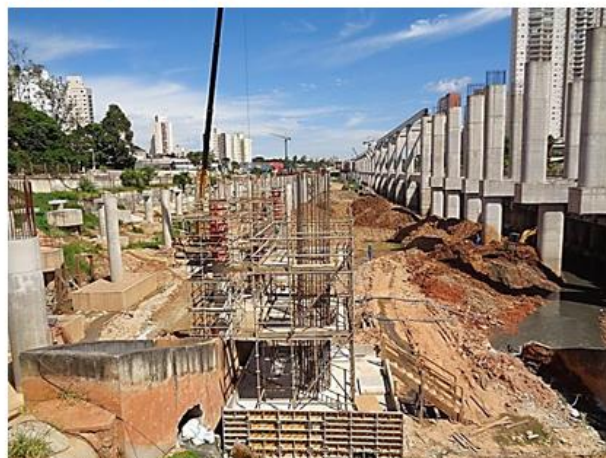
Pátio Água Espreiada – Execução de blocos e pilares.
