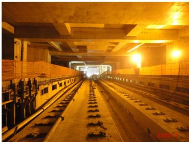
Lajes do sistema massa-mola concluídas
