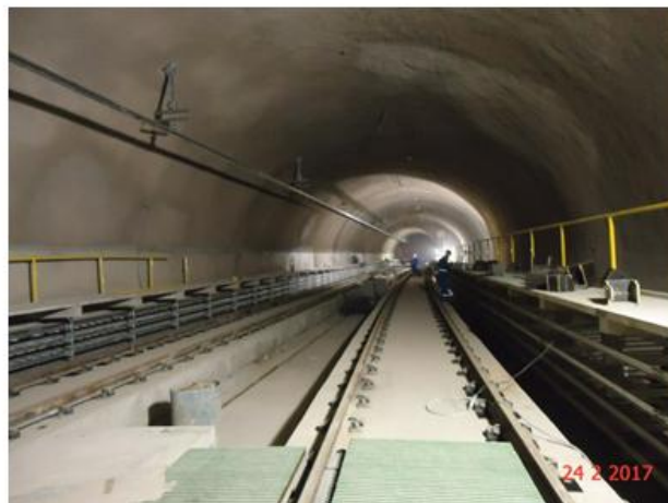
Instalação do guarda corpo e corrimão no trecho Brooklin – Campo Belo
